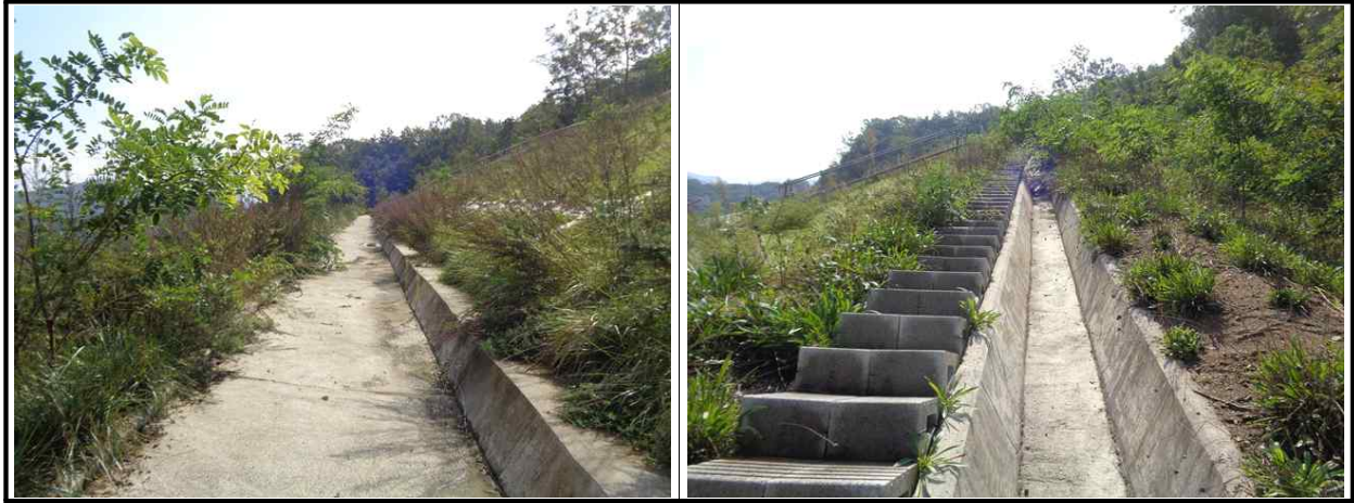
【그림 21.3.3】 배수시설 전경
